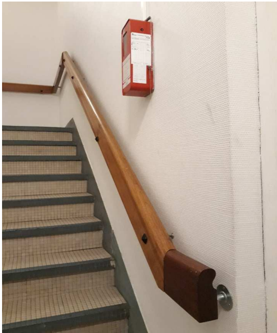
Mise en conformité des escaliers
