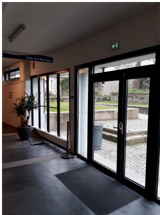
Mise en conformité des portes
