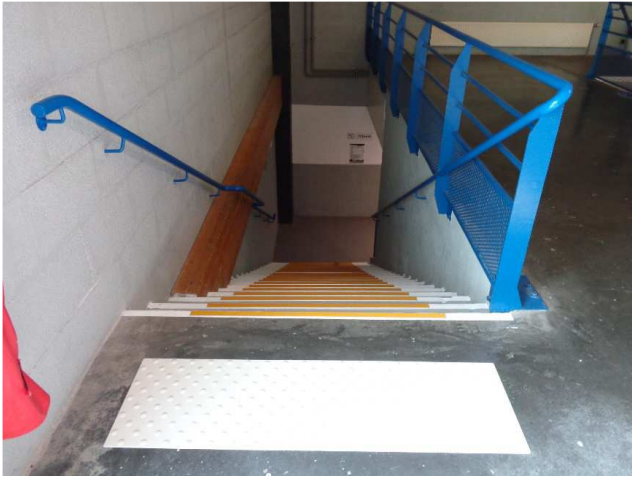
Mise en conformité de l'escalier
