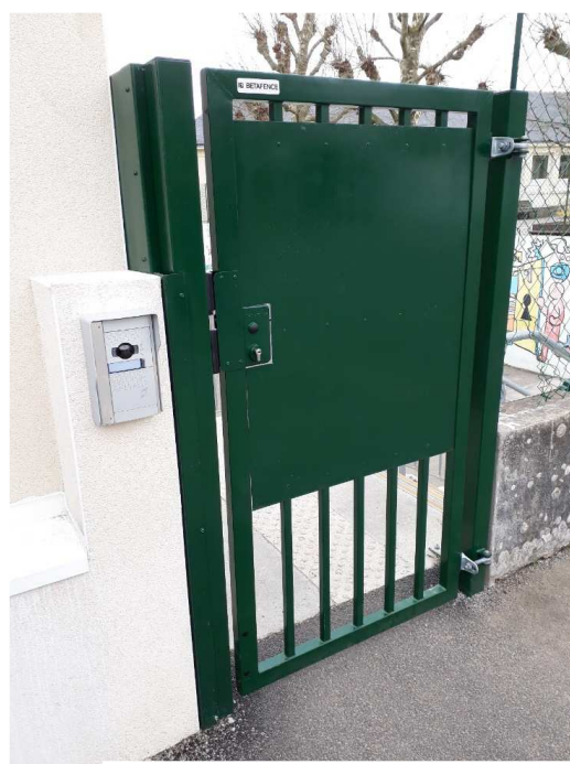
Portique et contrôle d'accès adapté
