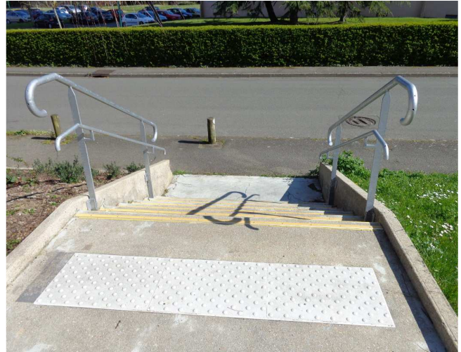
Mise en place des bandes podotactiles
