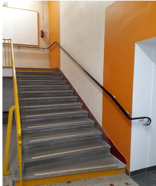
Sécurisation des escaliers
