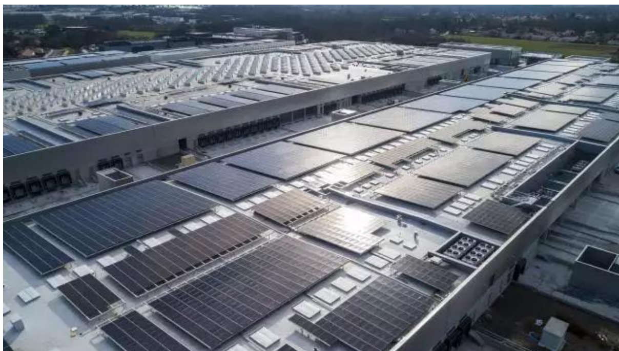
Commune de Rezé - Le surtoit du MIN et ses 31 000 m 2 de panneaux photovoltaïques, exploités par Armor green. © Valéry Joncheray/Nantes métropole
